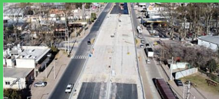
Colonia Caroya: etapa final del nuevo viaducto en Av. San Martín
